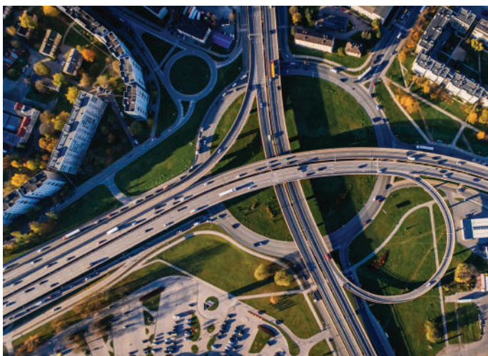
XÂY DỰNG HẠ TẦNG KỸ THUẬT GIAO THÔNG
